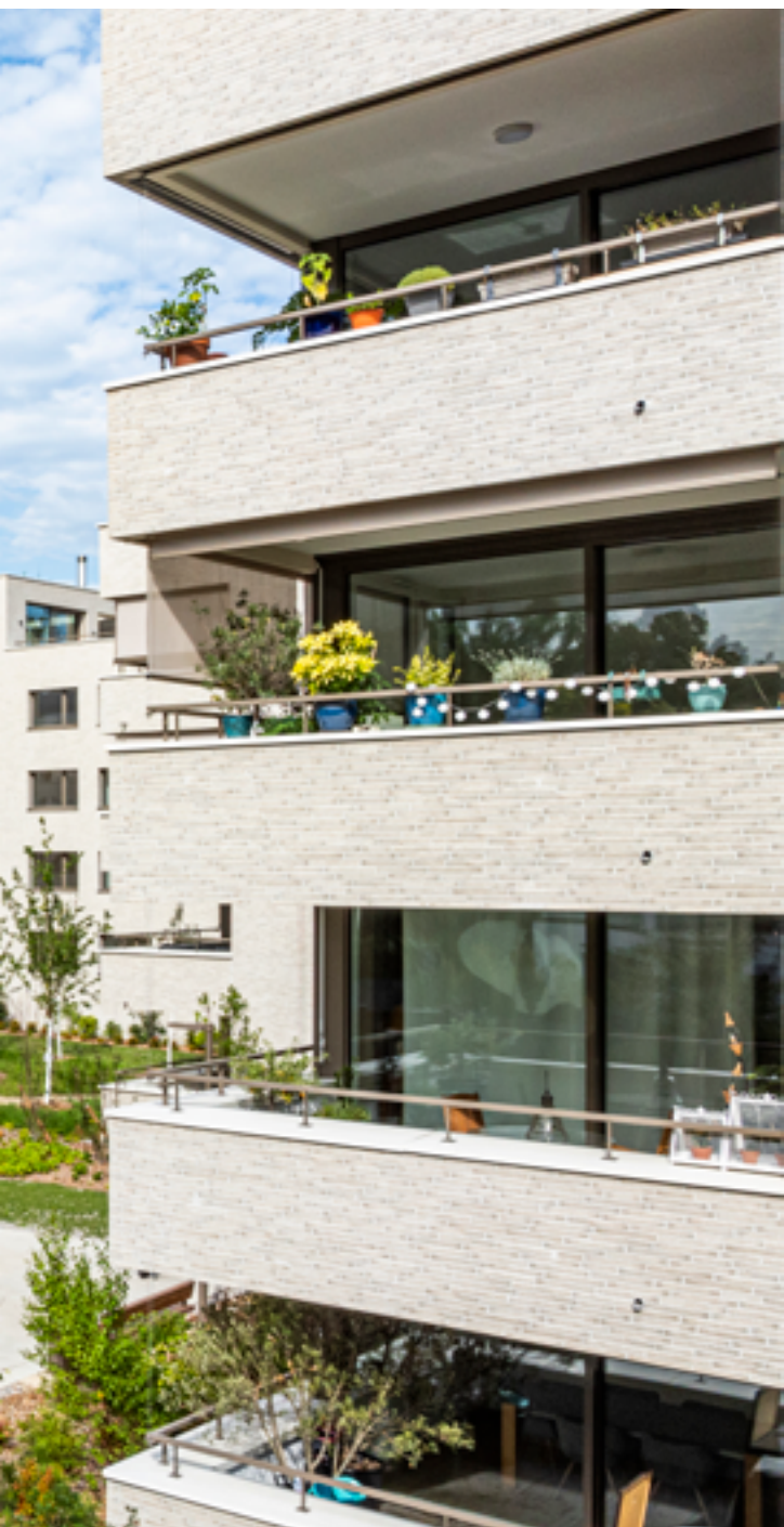
Le détail du revêtement des façades en briquettes.
