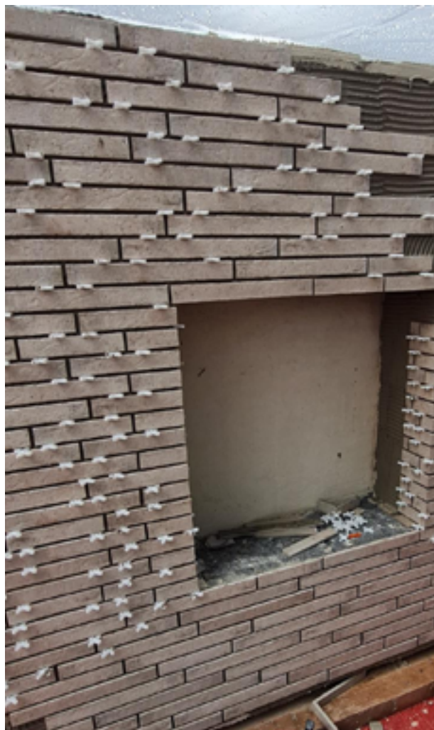
Le détail du revêtement des façades en briquettes.
