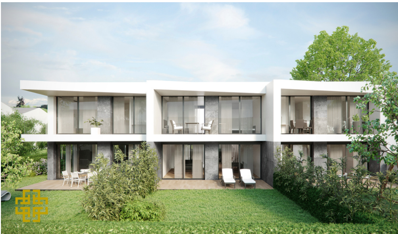
Vue des façades Sud-Est
